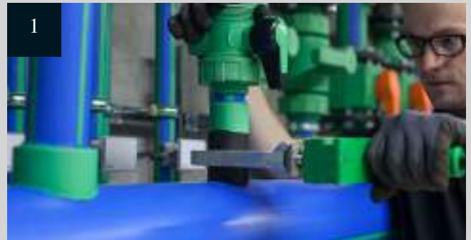
Приварка наварного седла на главную трубу
