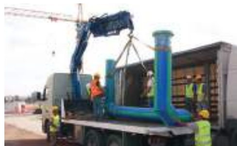
Доставка на стройплощадку
