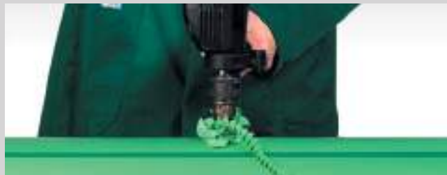
Сверление отверстия в стенке трубы
