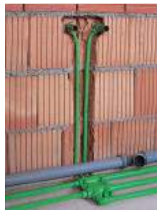
Монтаж под штукатурку
