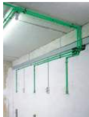
Монтаж на штукатурку
