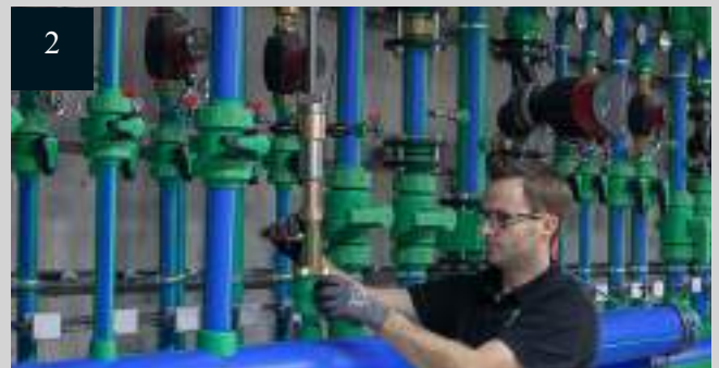
Установка сверильного инструмента на блок наварного седла
